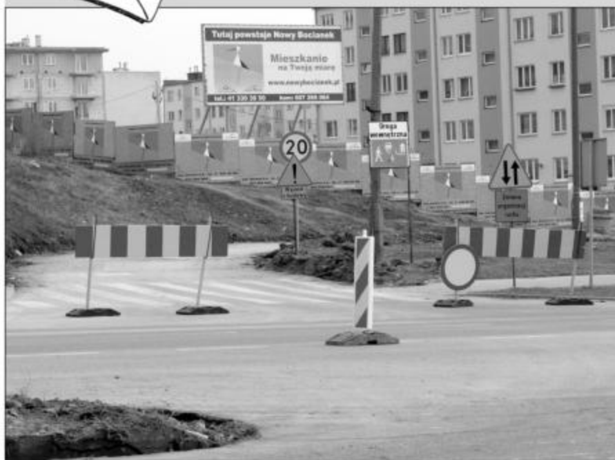
Prace przy wyjeździe / wjeździe już trwają...
