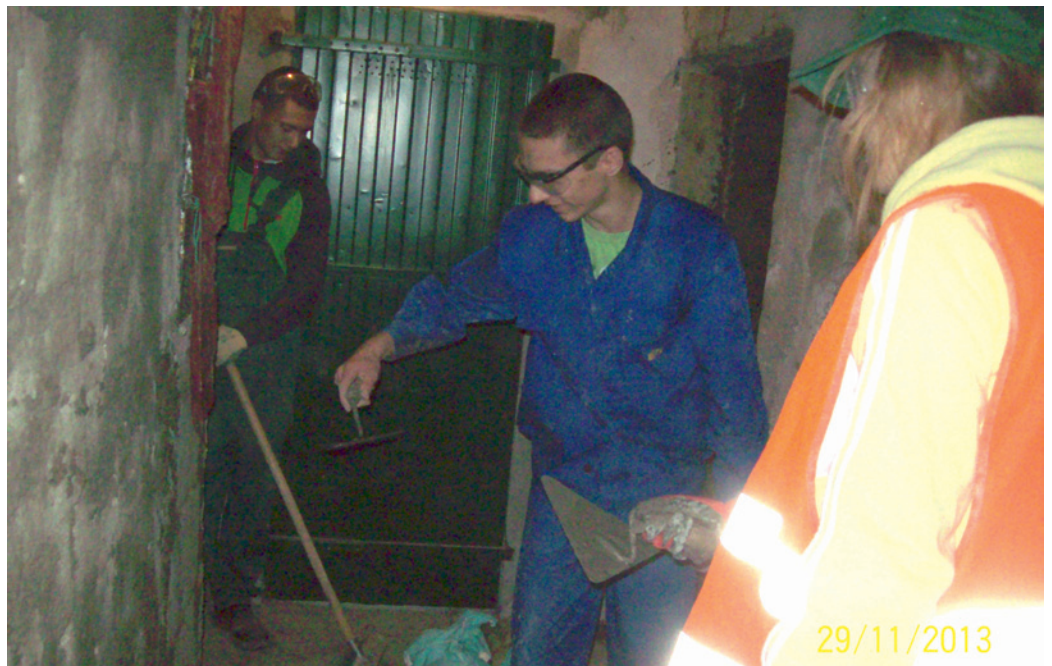
Uczniowie „Budowlanki” tynkują obecnie ściany blokowych piwnic.
