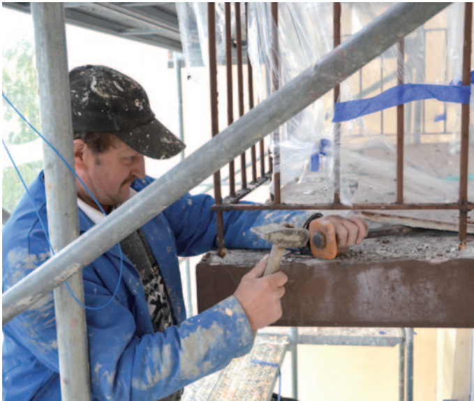
Robotnicy skuwają stare płytki i układają nowe.
