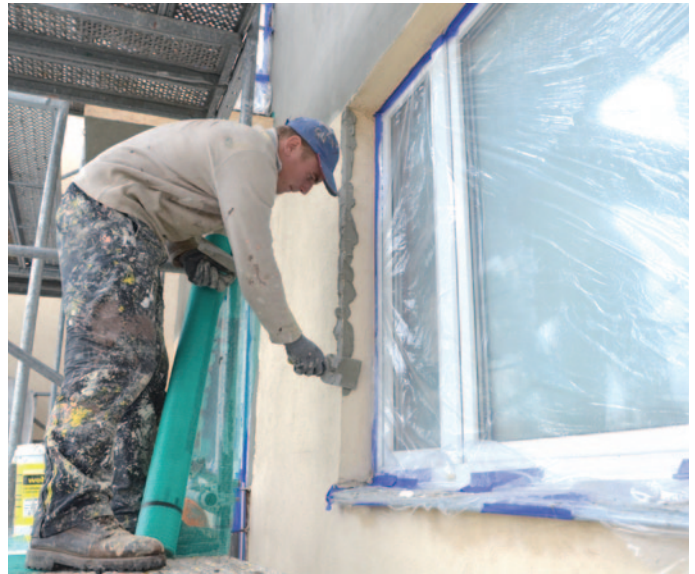
Przy okazji usuwane są pęknięcia w tynku.
