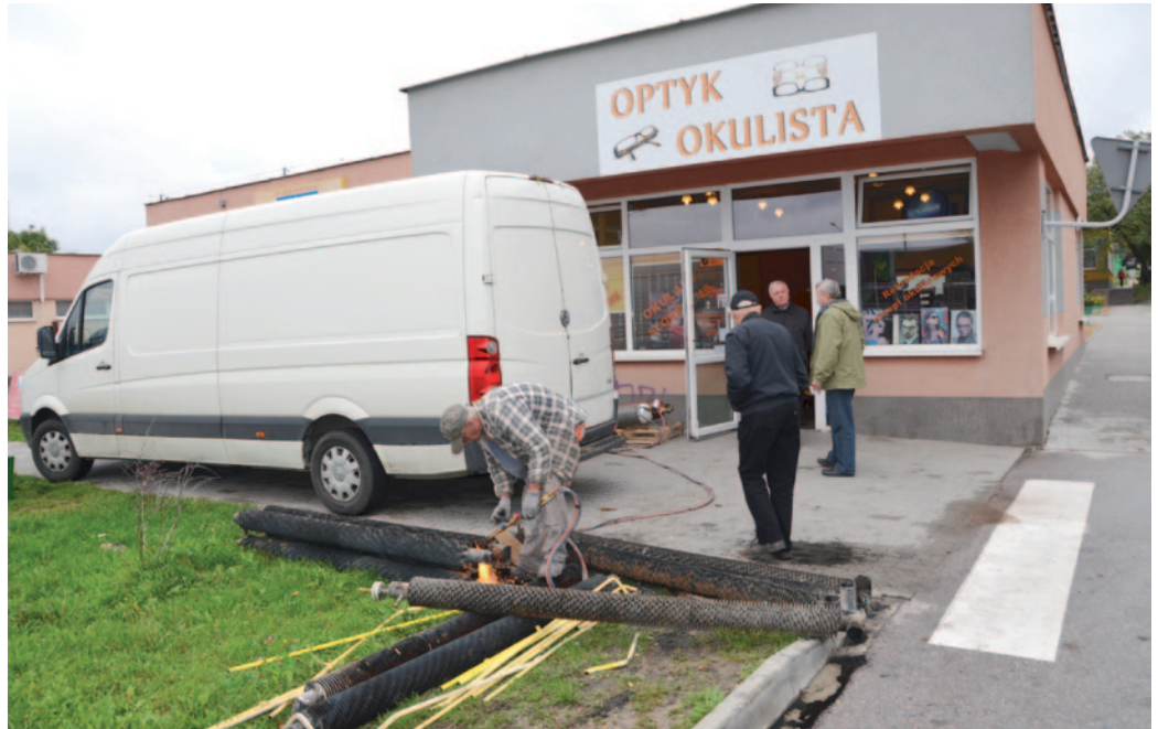
Robotnicy zdemontowali stare rury fawiera i zainstalowali w pawilonach nowoczesne grzejniki.
