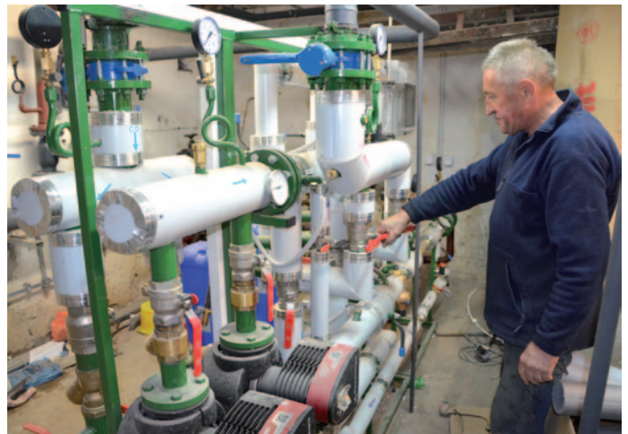
Powstał także nowy węzeł cieplny, który zastąpił dwa stare.
