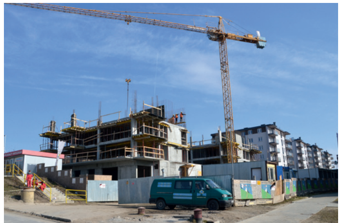
Trwa II etap budowy osiedla Nowy Bocianek. Chętnych na mieszkania nie brakuje.
