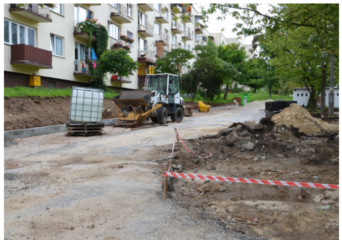
Remontowana ulica Wyspiańskiego.
