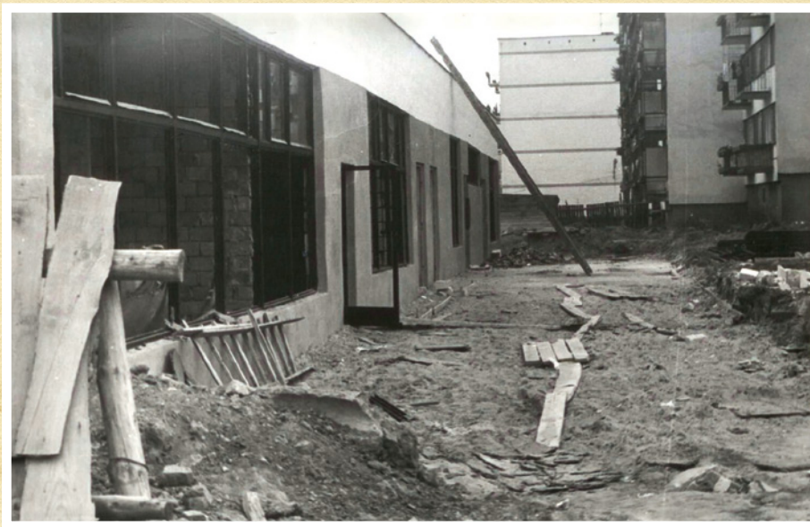
Archiwalne zdjęcie obrazujące budowę osiedla Bocianek. Na fotografii widać jeden z pierwszych pawilonów handlowych.
