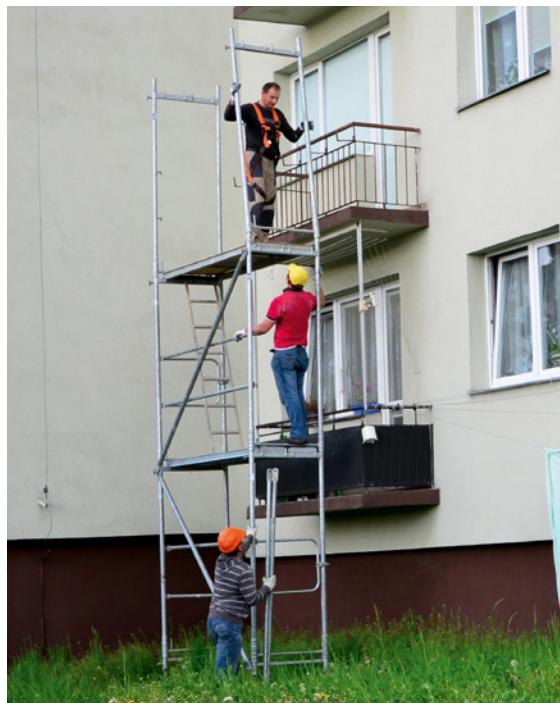
Wkrótce na Bocianku rozpoczną się kolejne remonty balkonów.
