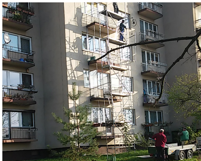
Ekipa budowlana remontuje balkony w bloku przy Konopnickiej 7.
