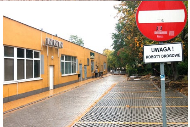
Efekt prac brukarzy od strony ul. Boya-Żeleńskiego.
