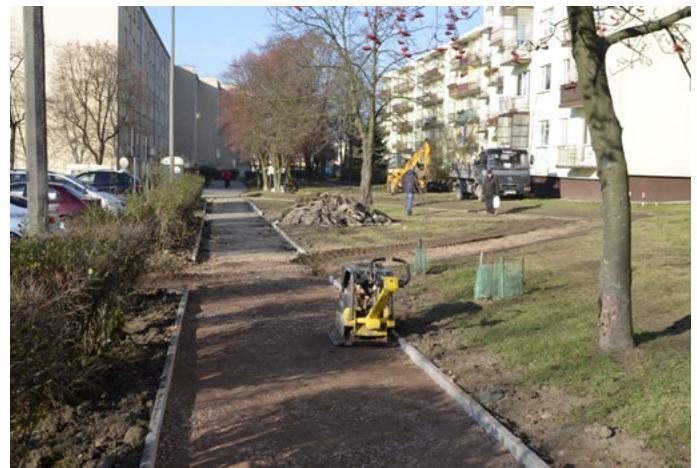
Chodnik przed blokiem przy Konopnickiej 11 - jeszcze w budowie.
