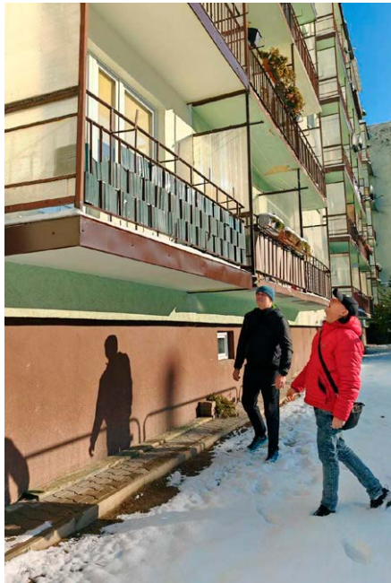
Grzegorz Zając i Marcin Hatlapa podczas odbioru remontów balkonów.
